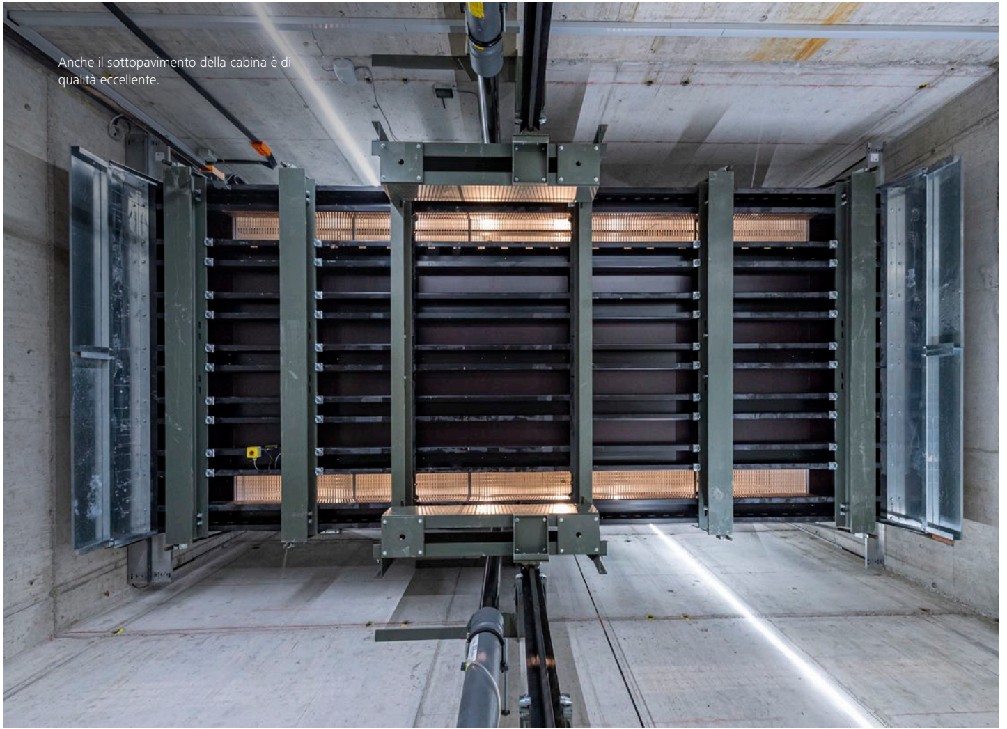
Soglie in acciaio zincato e barre paraurti proteggono la cabina dagli urti.
