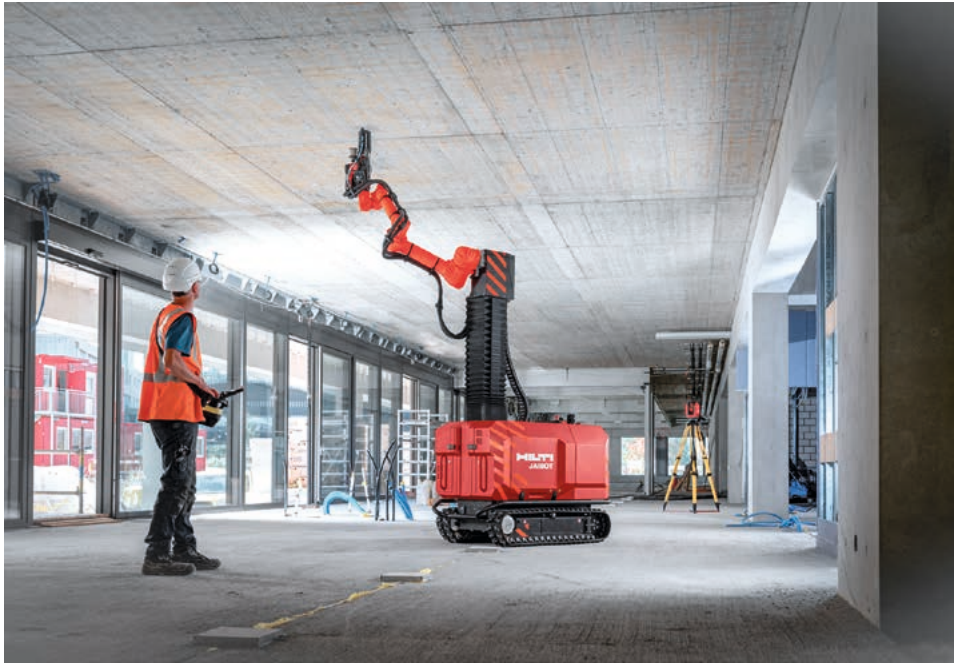
Il Jaibot di Hilti si prende cura dei compiti che gli esseri umani di solito trovano difficili. Pratica fori sul soffitto senza stancarsi.
