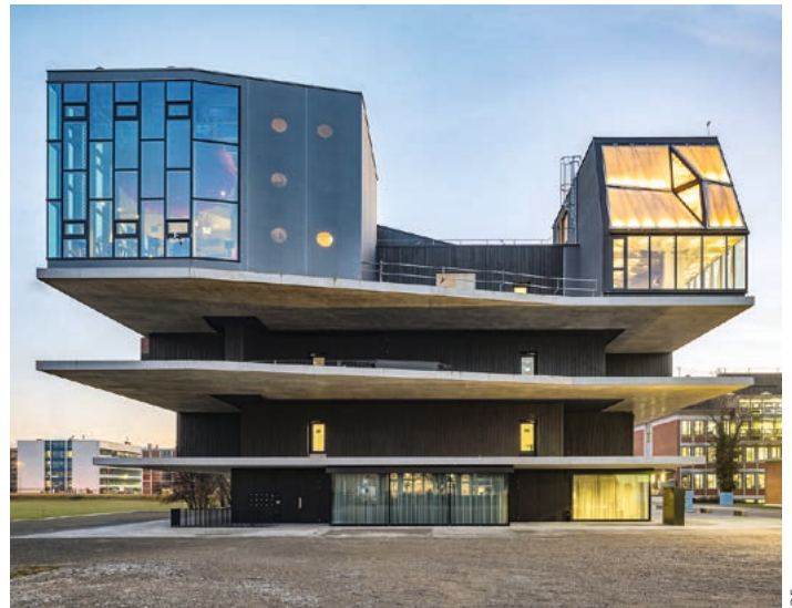
La DFAB House si trova sulla piattaforma più alta dell'edificio di ricerca e innovazione NEST.
