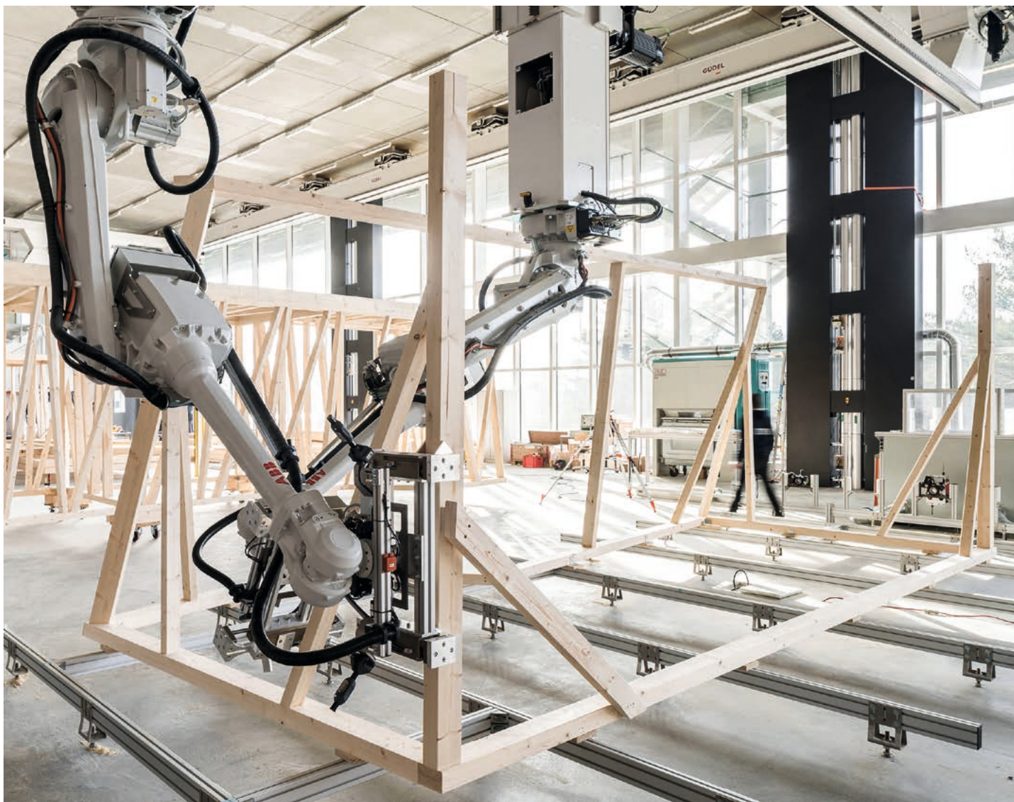
Spatial Timber Assemblies permette geometrie uniche nella DFAB House.
