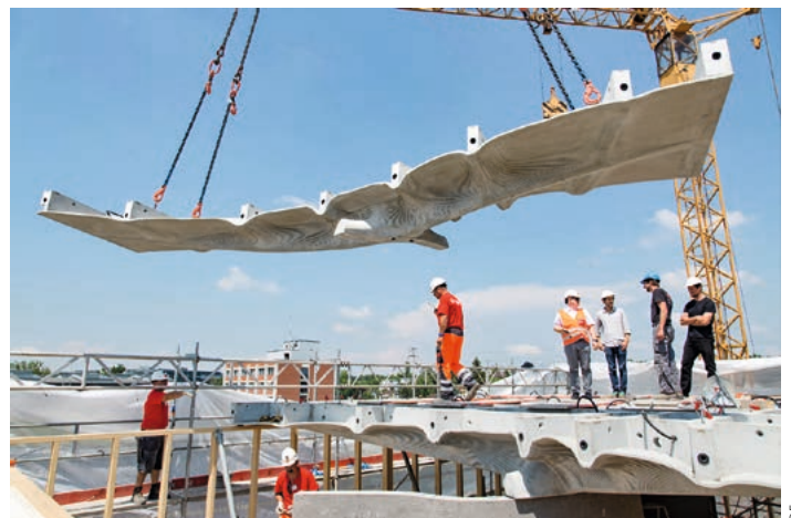
Un elemento del soffitto viene posizionato nella DFAB House; i fori nelle nervature servono al successivo pretensionamento.
