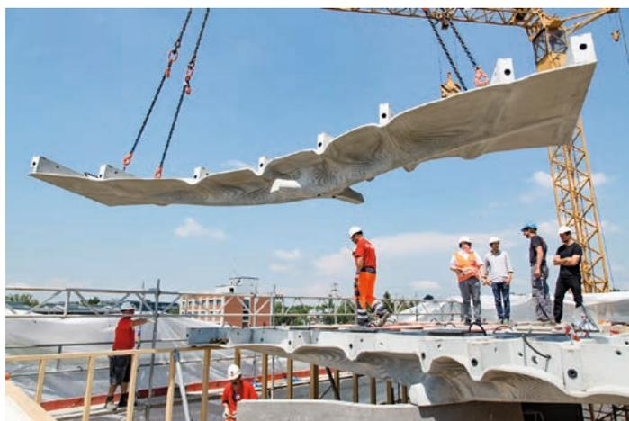
Un élément de plafond est mis en place dans la DFAB House, les trous dans les nervures sont destinés à la précontrainte ultérieure.
