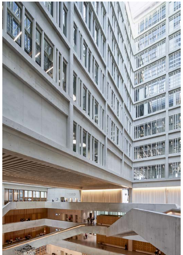
Une suspension élégante: un laboratoire de huit étages et une aile de bureaux «flottent» au-dessus du foyer.
