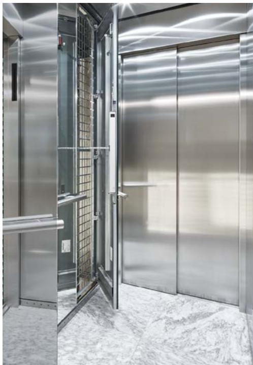
Der Liftschacht wird zum «Kamin»: Im Brandfall öffnet sich die Seitenwand des Aufzugs und der Rauch entweicht in den Schacht.
