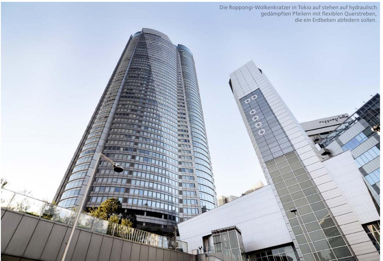
Die Roppongi-Wolkenkratzer in Tokio auf stehen auf hydraulisch gedämpften Pfeilern mit flexiblen Querstreben, die ein Erdbeben abfedern sollen.
