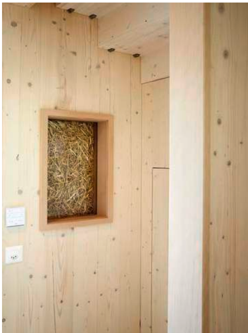
Im Eingangsbereich wird die Strohdämmung mittels Schaufenster sichtbar gemacht (oben). Die geschickte Anordnung der drei Baukörper bringt dörfliche Nähe (rechts) und viel Natur in die Siedlung (unten).
