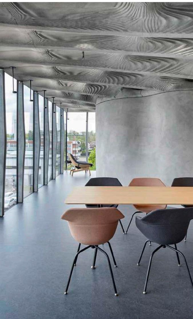
Coques de plafond en béton coulé sorti de l'imprimante 3D dans l'immeuble expérimental NEST de Dübendorf.
