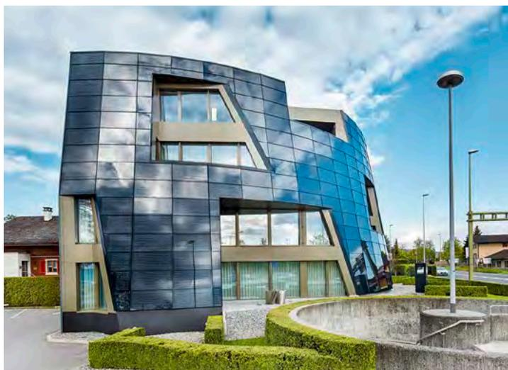
Die komplett mit Solarzellen verkleideten Fassaden verleihen dem Bürogebäude der BF Architekten in Sursee ein futuristisches Aussehen. Sie signalisieren damit auch die zukunftsweisende Haltung des Architektenteams, das in diesem Gewerbegebäude arbeitet.
