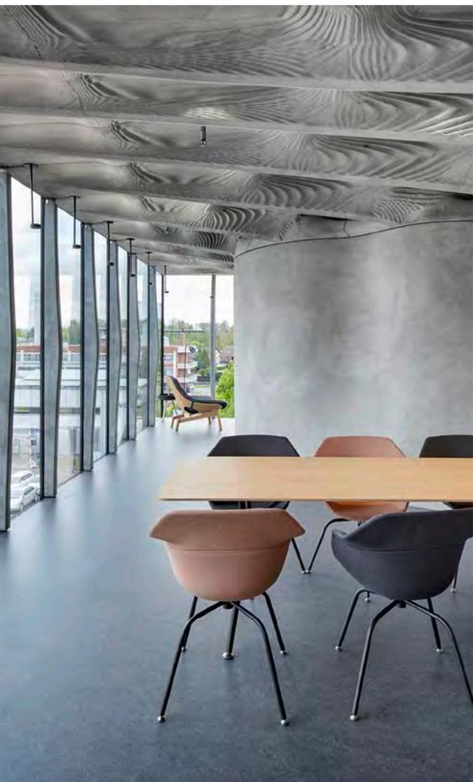
Betonguss-Deckenschalen aus dem 3D-Drucker im Experimentierhaus NEST in Dübendorf.
