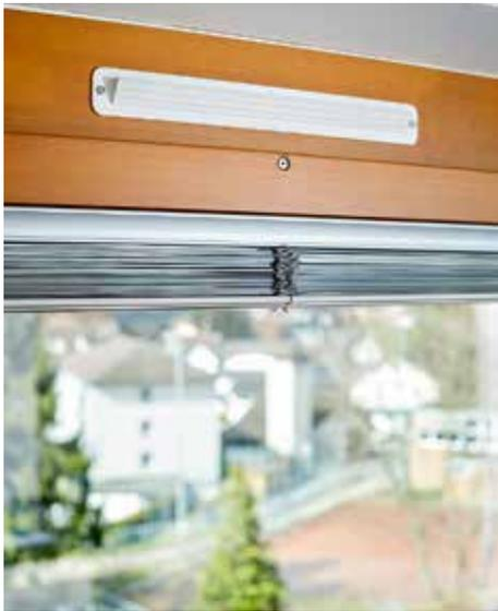
Le concept de ventilation basse technologie repose sur le passage de l'air extérieur (ailette blanche).
