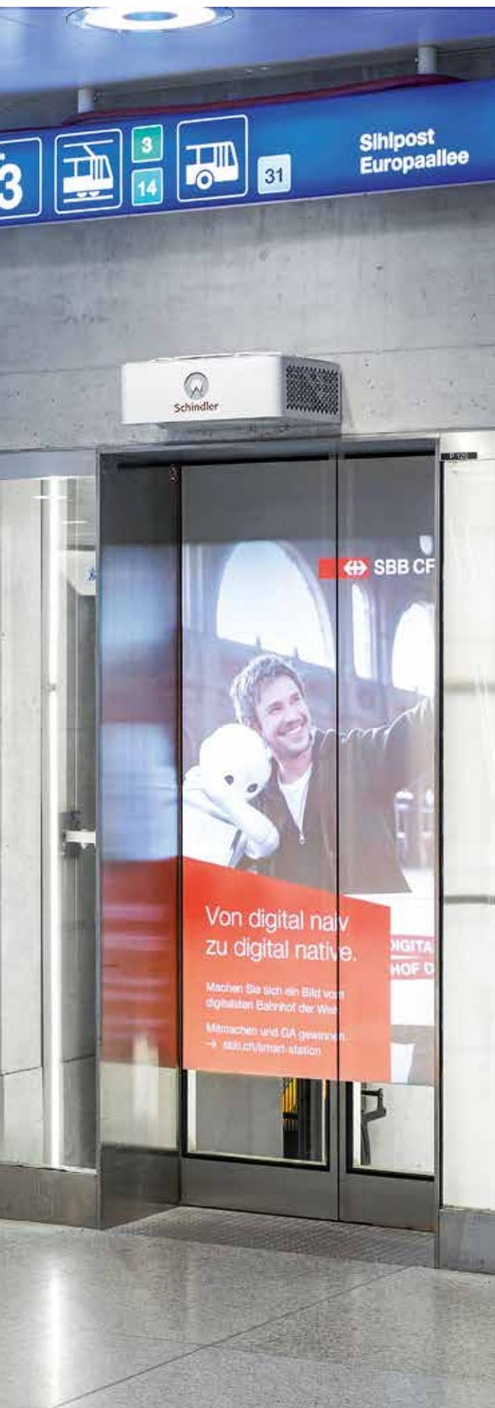
Le Schindler DoorShow permet d'utiliser les surfaces existantes, p. ex. à des fins d'information.
