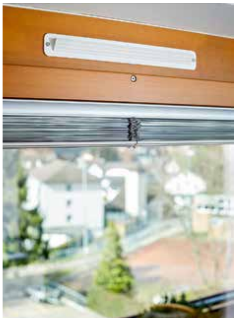
Der Aussenluftdurchlass (weisse Lamelle) ermöglicht das Lowtech-Lüftungskonzept.
