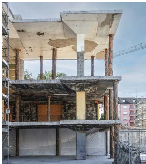
A sinistra, il deposito, quando ancora vi si conservava il vino. A destra, un'immagine della riconversione: le colonne a fungo fanno ancora oggi parte della struttura dell'edificio.
