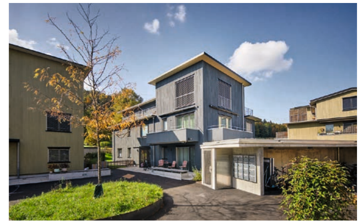
Il vano in legno è stato installato in questo edificio residenziale di Embrach, vicino a Winterthur.
