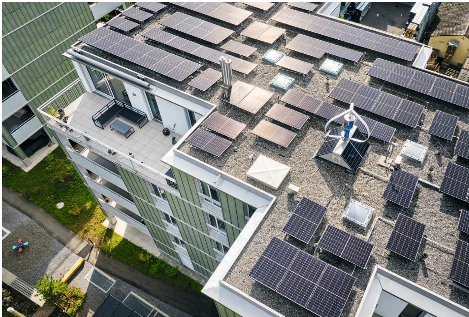
Una turbina eolica e due pannelli solari inclinati producono nell'arco dell'anno la stessa quantità di elettricità necessaria all'impianto ascensoristico.
