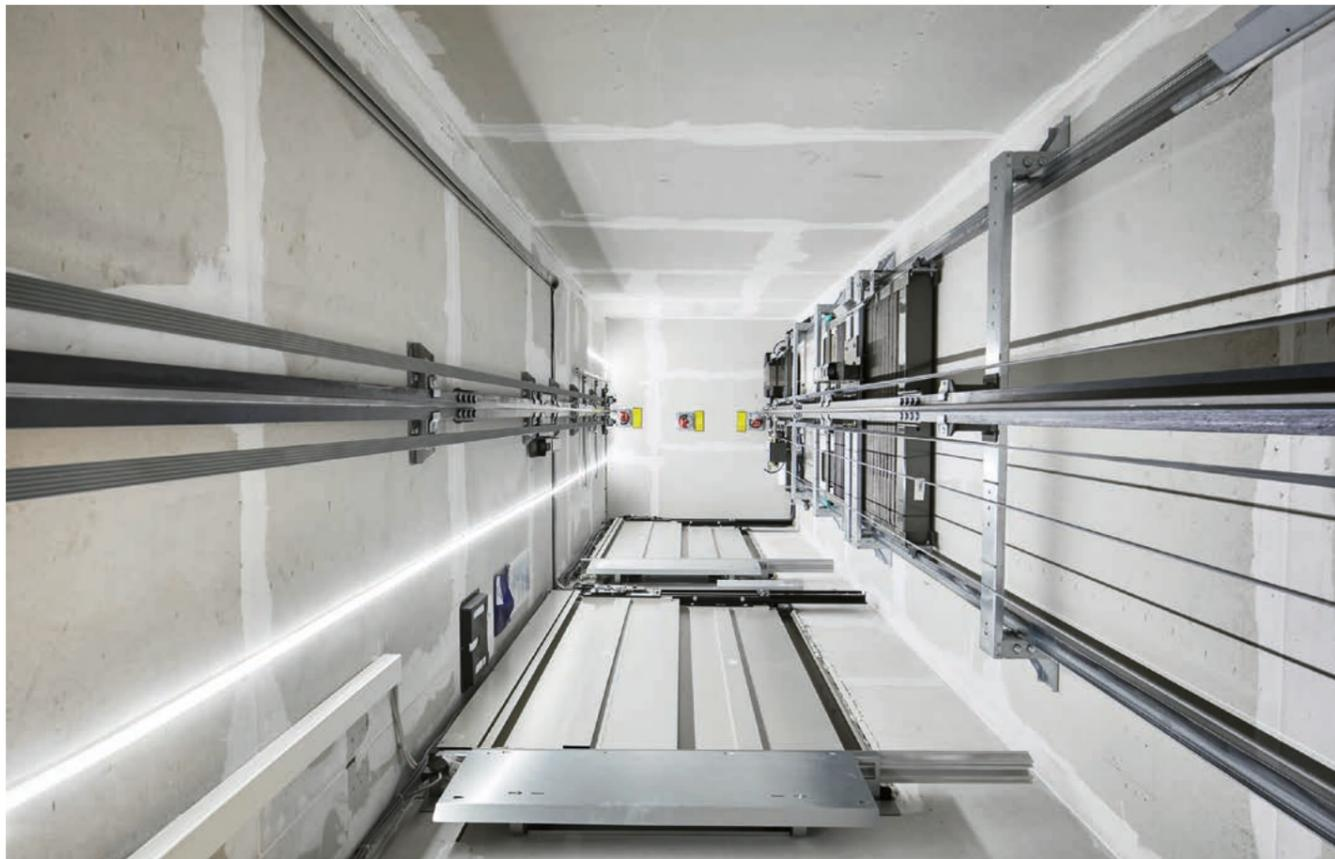
Au premier coup d'œil, la cage en bois n'est pas visible. En raison des prescriptions en matière de protection contre les incendies, elle doit être recouverte de panneaux en fibroplâtre (photo du haut).
