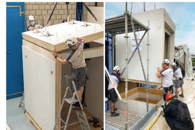
Dans les ateliers de Schindler, les modules de cage sont assemblés et la technique d'ascenseur est installée (photo de gauche). Ensuite, les modules sont acheminés vers le site de construction où ils sont montés.
