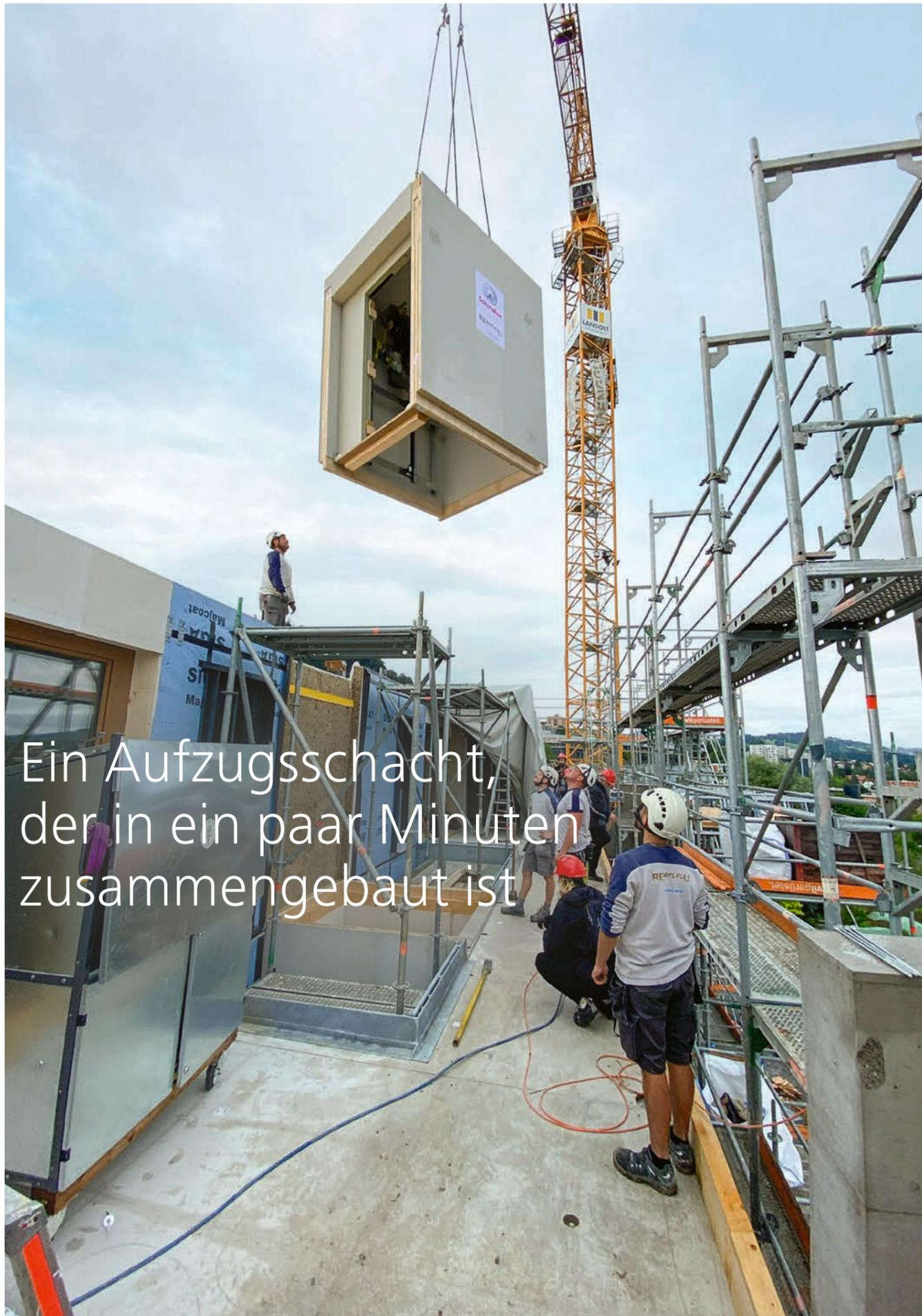
Ein Aufzugsschacht, der in ein paar Minuten zusammengebaut ist
