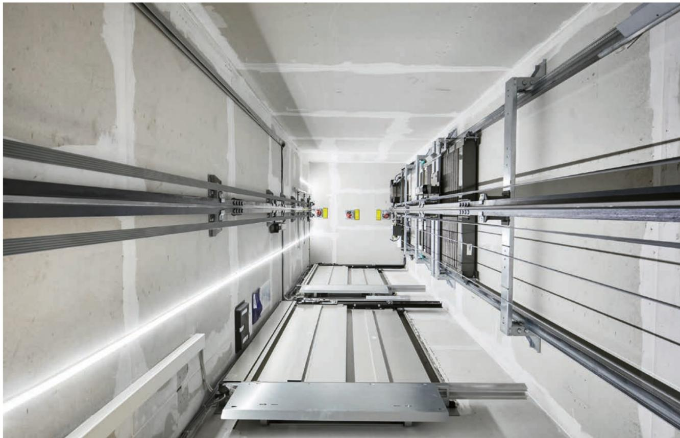
Auf den ersten Blick ist der Holzschacht nicht zu erkennen. Wegen Brandschutzvorschriften muss er mit Faser-gipsplatten verkleidet werden (Bild oben).
