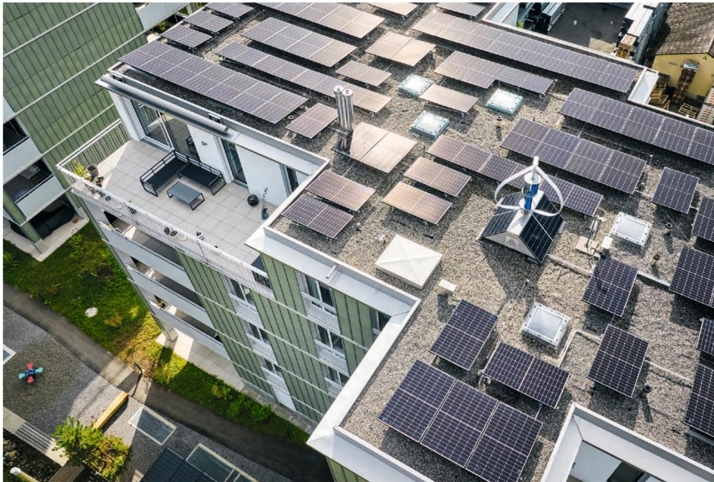
Eine Windturbine und zwei schräggestellte Solarpanels produzieren übers Jahr gleich viel Strom, wie die Aufzugsanlage benötigt.
