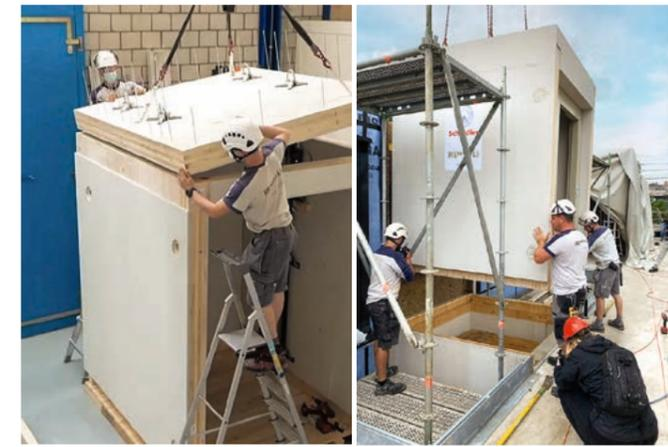
In den Werkräumen von Schindler werden die Schachtmodule zusammen- und die Aufzugstechnik eingebaut (linkes Bild). Danach folgt der Transport auf die Baustelle, wo die Module montiert werden.
