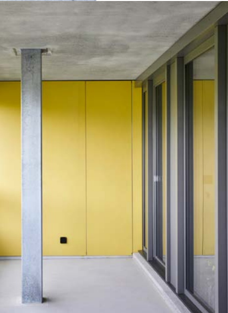
24 Aufzüge wurden in den Gebäuden demontiert und mit neuen Anlagen ersetzt. Sie passen optisch perfekt zu den Laubengängen und überzeugen auch punkto Stromeffizienz.
