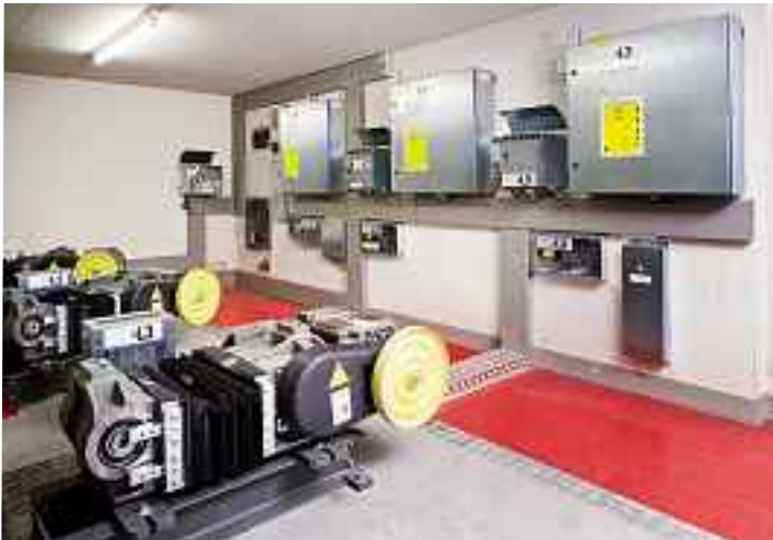
DR SGB 142 als 3er-Gruppe in einem Geschäftshaus in Verbindung mit einer CO MX-Steuerung
