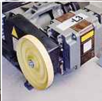
Volante d'emergenza in caso d'interruzione di corrente
