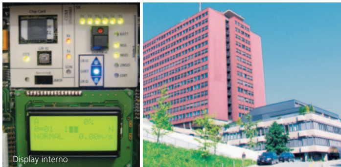
Quadro di manovra ed inverter
