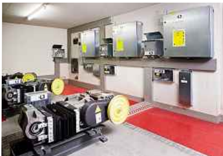
DR SGB 142 dans un triplex en liaison avec une commande CO MX, dans un bâtiment commercial
