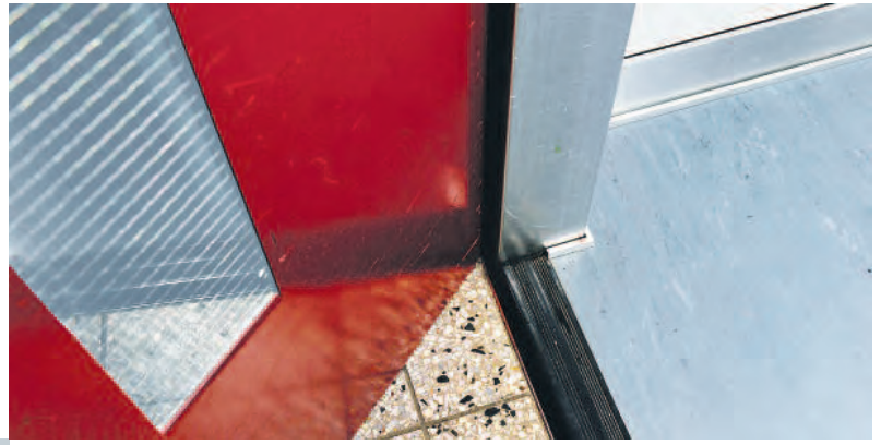
Die Anhaltengenauigkeit eines Aufzuges (Bild rechts) oder eine unzulängliche Notrufeinrichtung (Bild unten) verbessern, das fordert die europäische Norm SNEL.
