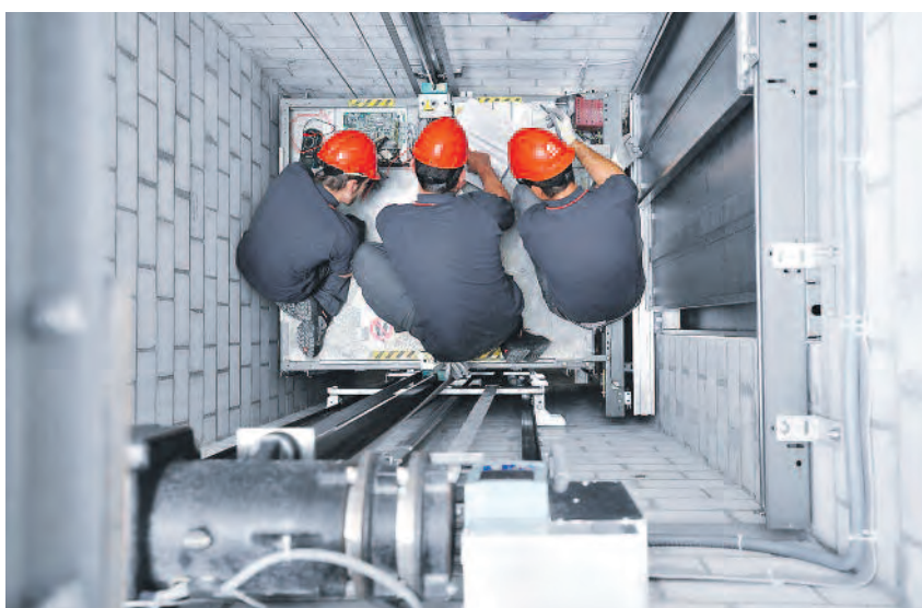
Drei Modernisierungsmonteure besprechen im Übungsschacht im Lift Camp die Aufgabe.
